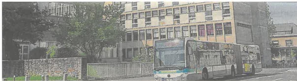
En 2024, les travaux devraient débuter, rue de Fougères, dans le bâtiment de la faculté de droit et de science politique.
